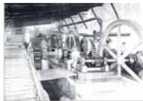
Atividade na Usina
