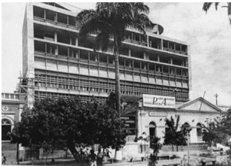
Fig. 9: A fachada do antigo Palácio Alencastro serve de tapume para a obra de construção do novo Palácio Alencastro
