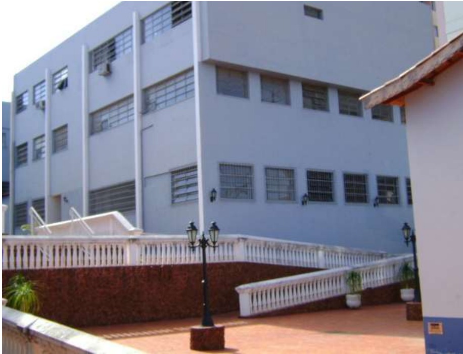
Edifício da antiga Faculdade de Direito. O Arquivo e Biblioteca estão alojados na parte interior, logo após as rampas.
