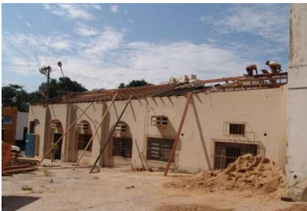
Intervenção nas partes externa do casarão do Barão de Melgaço. Acervo IHGMT
