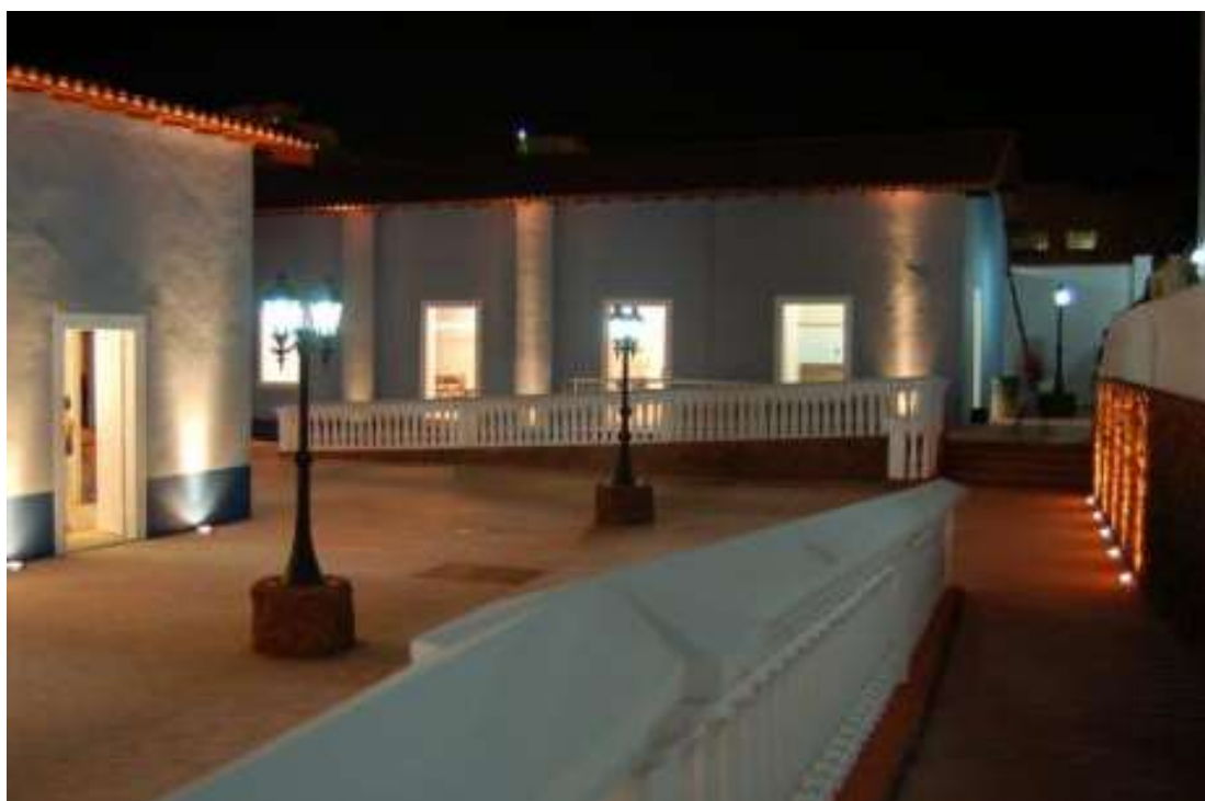
Pátio externo restaurado e adornado com escadas, rampas e colunas. Acervo IHGMT
